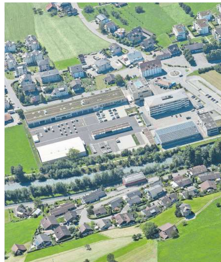
Die Halle soll auf der Wiese links vom bestehenden Kasernenareal zu stehen kommen (linker Bildrand). Bild: PD
